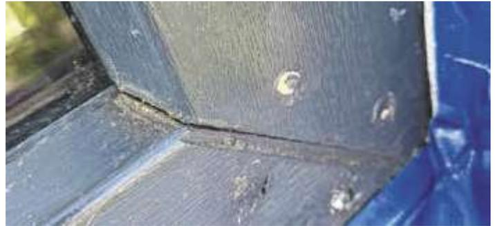
*/ Gerissene Ecken, die über Bohrungen auf der Außenseite mit eingespritztem 2K-Material verfüllt wurden, sind nach einem Jahr später erneut gerissen.*
