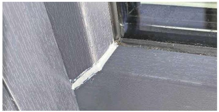
*/ Anschließend wird die Ecke mit einem 1K-Hybridklebstoff verfüllt.*
