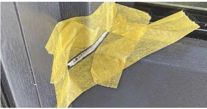
*/ Die gerissene Ecke wird bis mindestens zur ersten Kammer außen aufgefräst.*
