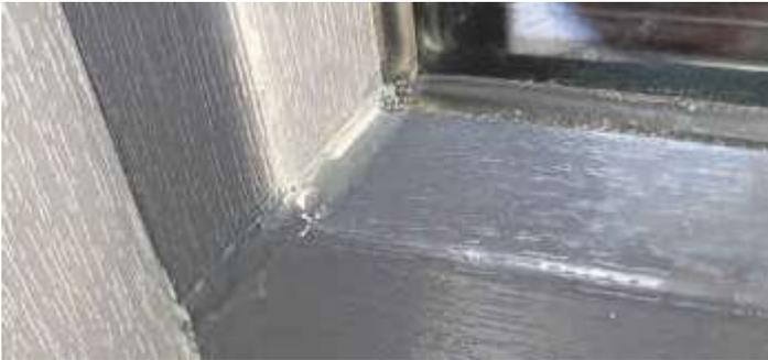
*/ Nachdem der Kleberüberschuss abgezogen wurde und eine Durchtrocknung von ca. 24 Stunden erfolgt ist, kann die Ecke eingefärbt werden.*
